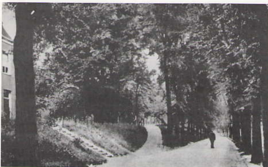
Wasserij aan Haringkade, 1917. Links ingang naar wasserij en directeurswoning
