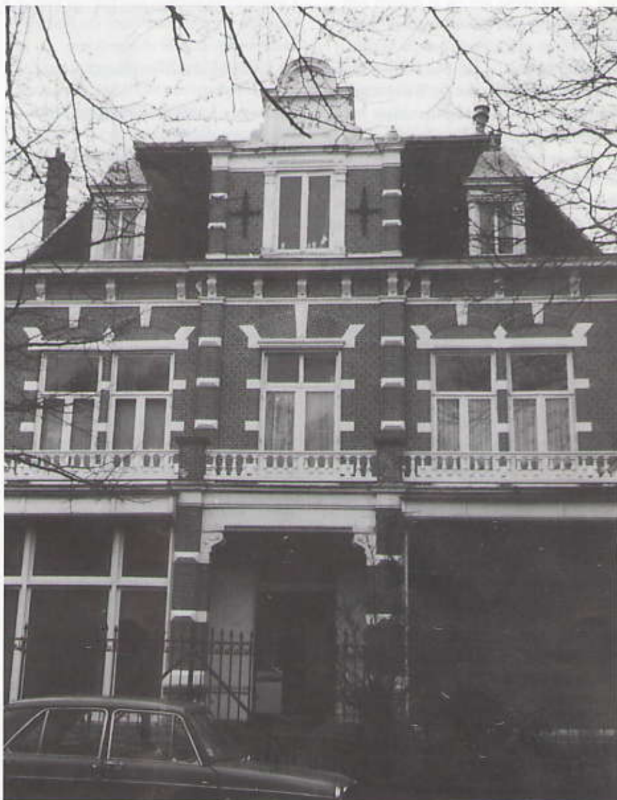
Parkweg 18, in 1894 gebouwd als onderdeel van de Psychiatrische Kliniek van Dr. Eykman: hard aan grondig herstel toe. (foto Anneke Landheer)
