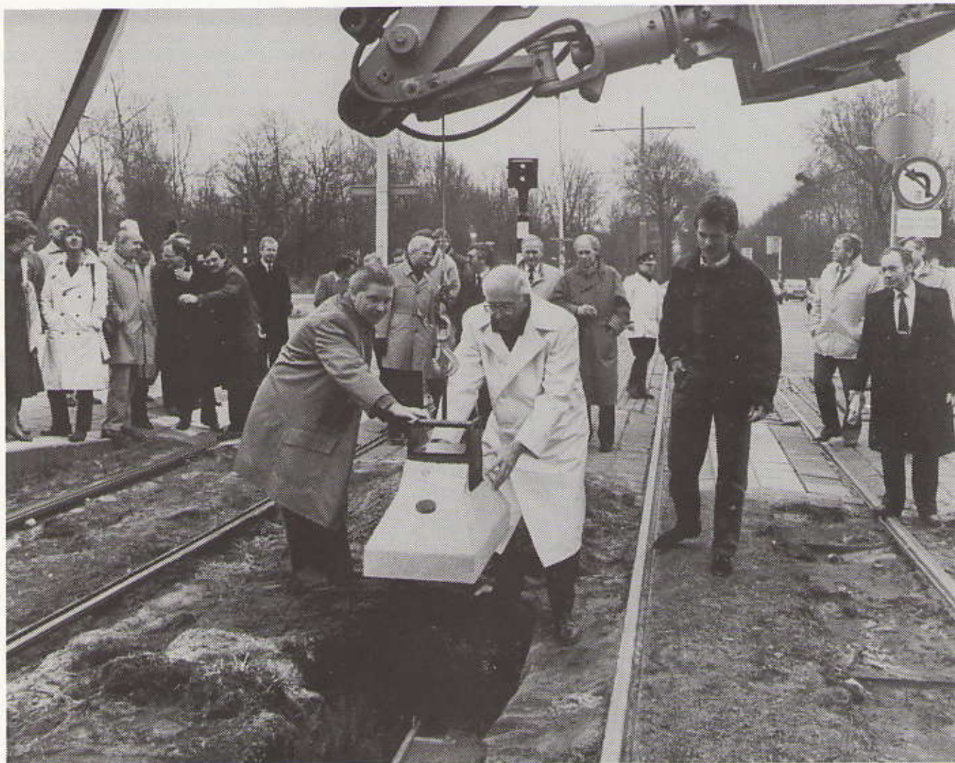
2 April 1986 - HTM-directeur Drs J. K. E. Dwarshuis verricht de officiële aanvangshandeling van de vernieuwing van de trambaan - de 'groefrailconstructie' - langs de Scheveningseweg, het inbrengen van de eerste betonnen funderingsvoet (foto Haagsche Courant, Karel Vereecken).
