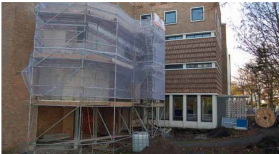
De sloop van het VCL is begonnen. De paardjes worden voorzichtig verwijderd.
